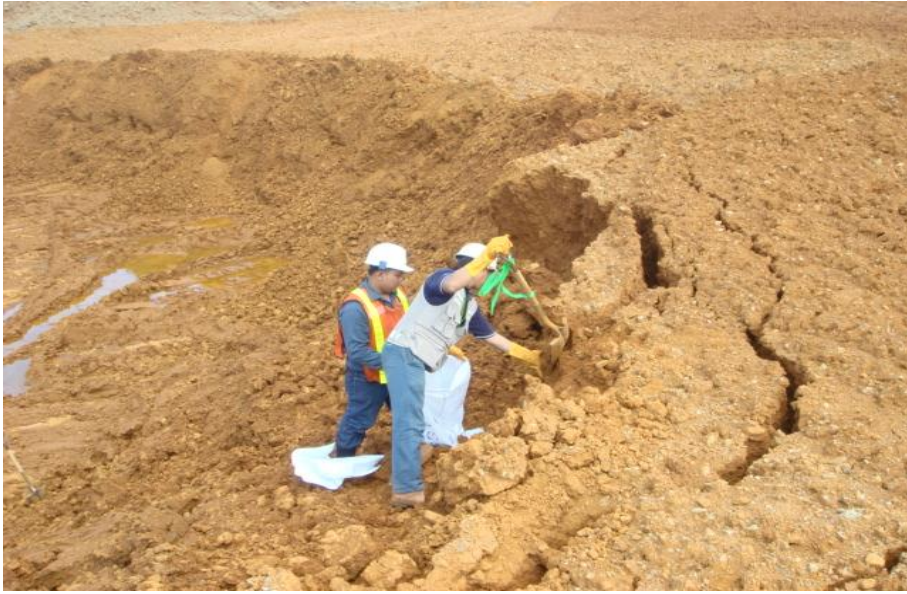
Gambar 4.3 Hasil survei lokasi dipasangi patok pembatas (foto pribadi)
